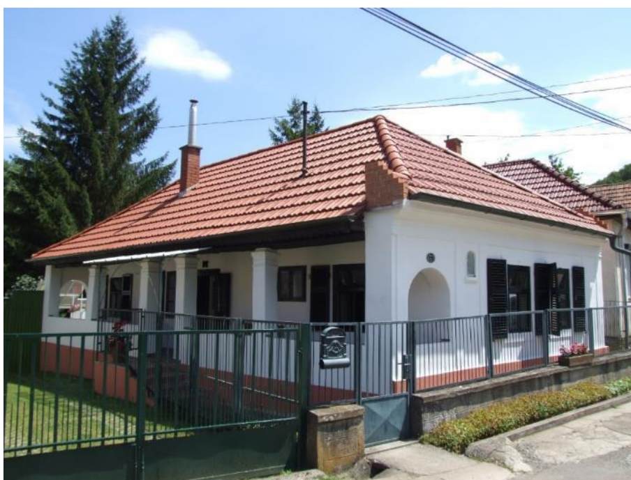
Felújított hagyományos népi épület
