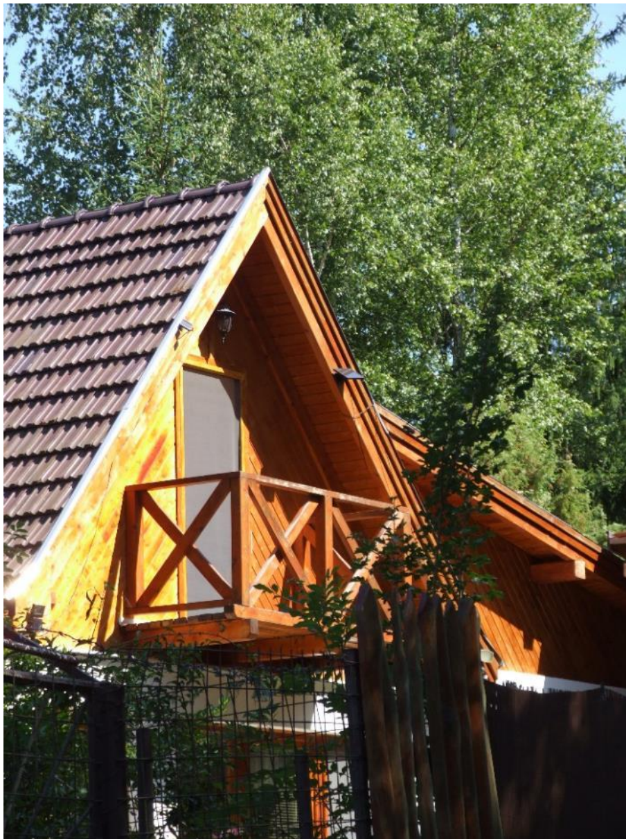
Léptékváltás ellenére hagyományokra épülő formakincs
