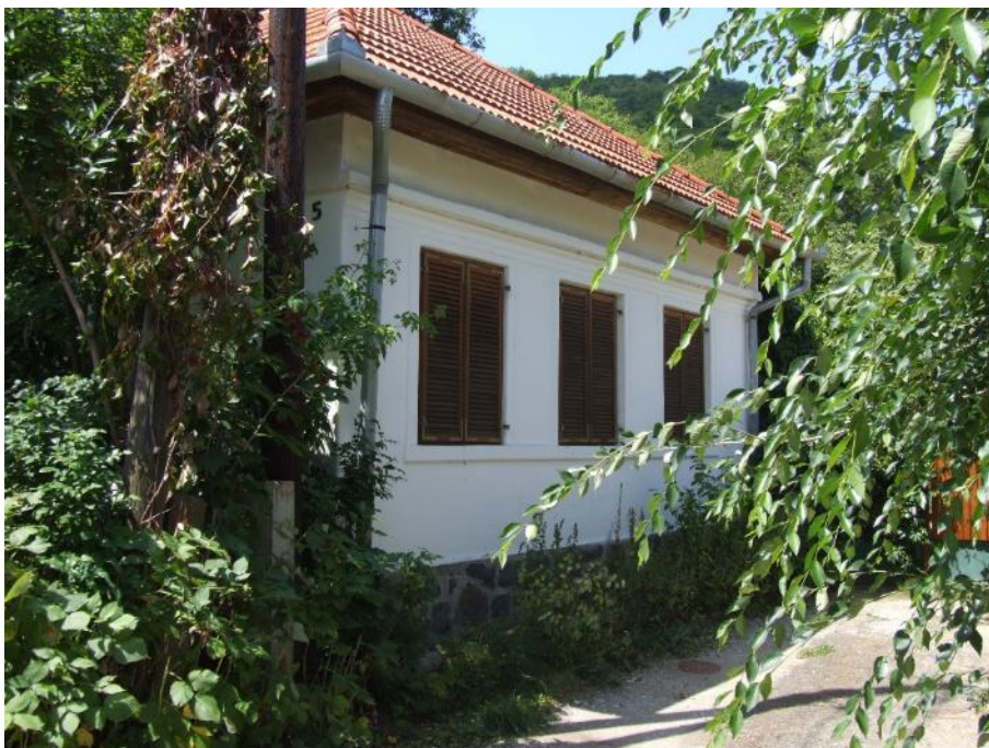
Természetes anyaghasználat (terméskő lábazat, fehér vakolat, fa nyílászáró, cserépfedés)
