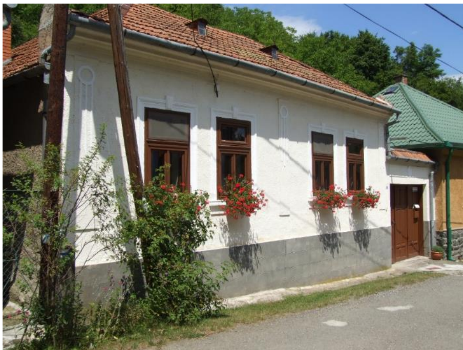
Megőrzött homlokzatzdíszítés és nyílásosztás
